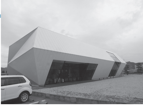
工場横に設けられたショールーム
